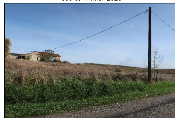
Ligne téléphonique au Sud-Ouest Source : Artifex 2020
